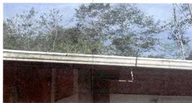
Foto 4: Sustitucion de canal pvc.
