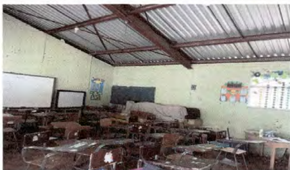
Foto 7: Pintura en muros exteriores e interiores, aula 2.
