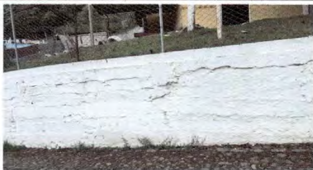
Foto 1: Aplicación de repello y cernido en muro.
