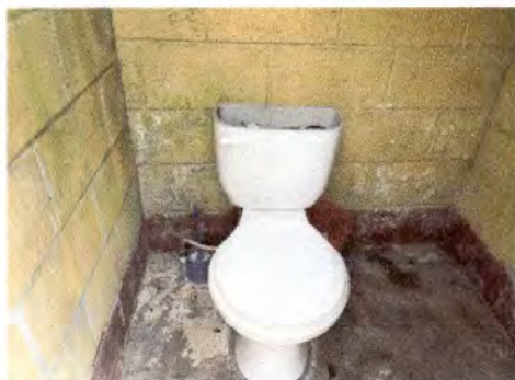
Foto13: Sustitucion de piso ceramico, inodoro, repello y cernido en pared.
