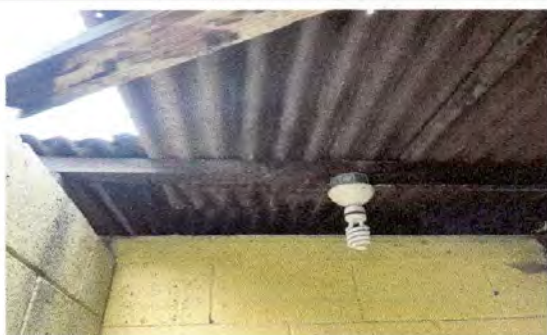
Foto 15: Sustitucion de estructura de soporte de madera por metal.
