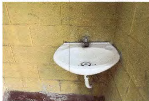
Foto 14: Sustutucion de lavamanos.
