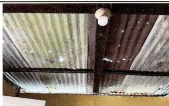
Foto 11: Sustitucion de estructura de soporte de madera, por metal.
