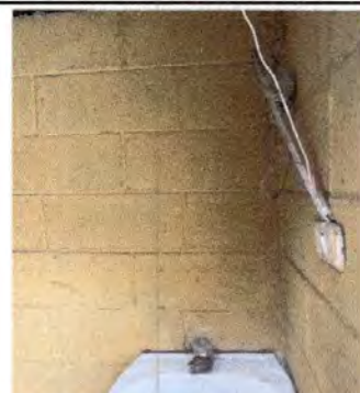
Foto 16: Sustitucion interruptores simples.
