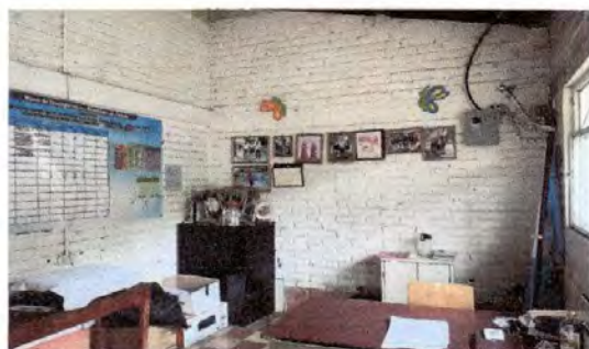
Foto 5: Pintura en muros exteriores e interiores, direccion.
