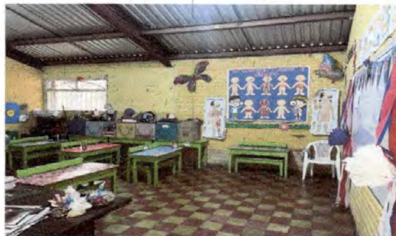
Foto 6: Pintura en muros exteriores e interiores, aula 1.
