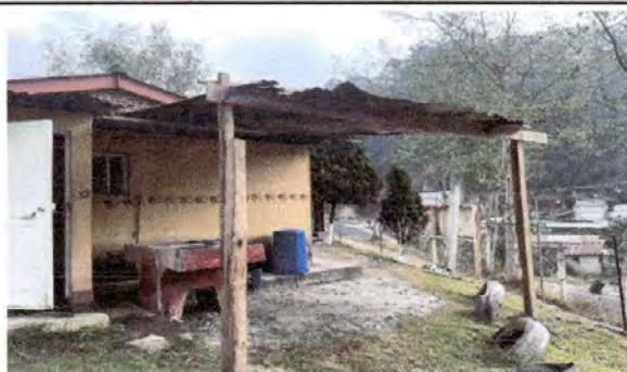
Foto 17: Sustitucion de pila de dos lavaderos y sustitucion de estructura de soporte de madera por metal.
