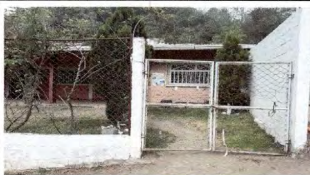
Foto 2: Fabricacion de porton de metal de ingreso.
